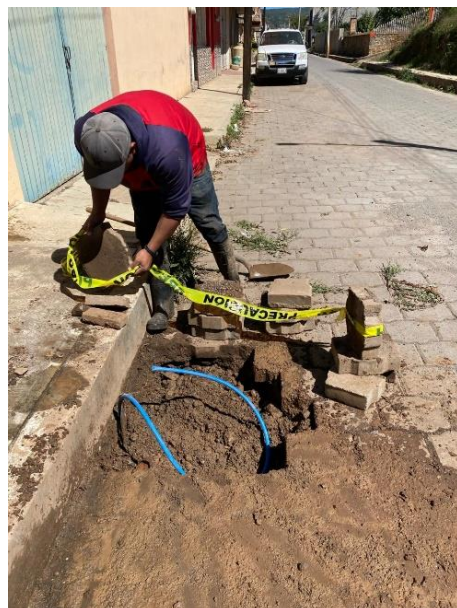
REPARACION DE FUGAS DE AGUA EN MANGUERA
