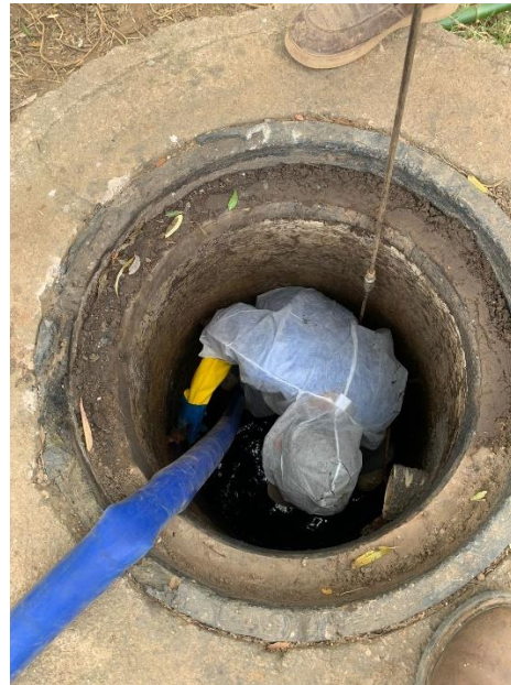
Rehabilitación de un pozo de visita en la calle Nicolas Regules esquina con el rio,
