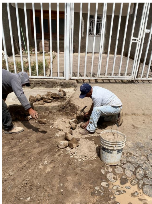
EMPEDRADO POR REPARACION DE FUGA DE AGUA
