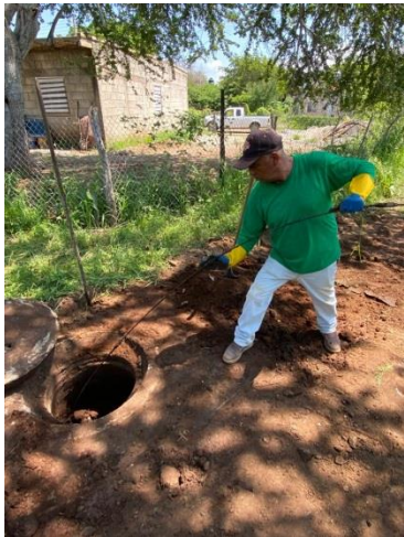
DESTAPONAMIENTO DE DRENAJE EN AMADO NERVO
