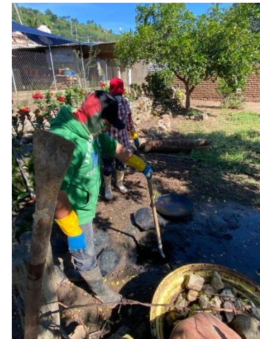
DESTAPONAMIENTO DE DRENAJE EN GUASIMAS
