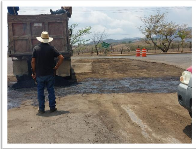
Apoyo en Bacheo de Av. Terebintos.
