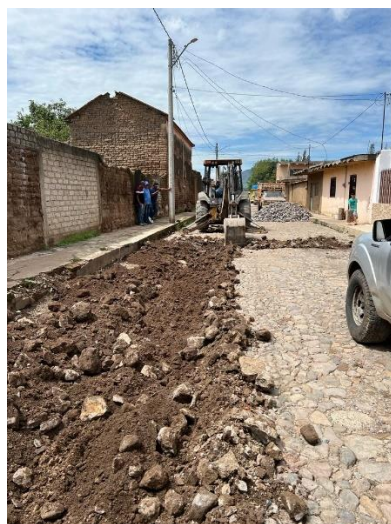
Reposición de empedrado en zanjas en calle Matamoros entre Altamirano y Leandro Valle en la cabecera municipal de San Pedro Lagunillas
