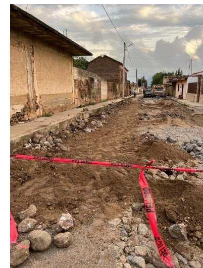
Reposición de empedrado en zanjas en calle Matamoros entre Altamirano y Leandro Valle en la cabecera municipal de San Pedro Lagunillas
