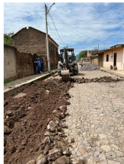
Reposición de empedrado en zanjas en calle Matamoros entre Altamirano y Leandro Valle en la cabecera municipal de San Pedro Lagunillas
