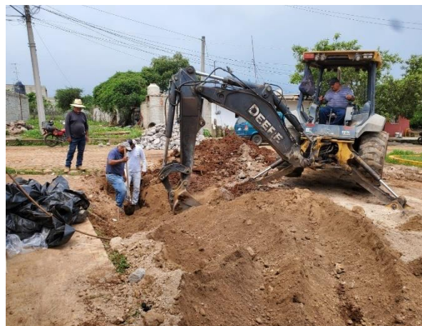
Reposición de empedrado en zanjas en calle Matamoros entre Altamirano y Leandro Valle en la cabecera municipal de San Pedro Lagunillas
