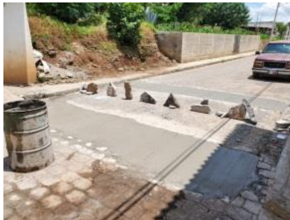
Se realiza marcaje de baches y levantamiento de volúmenes para el proyecto de bacheo de la carpeta asfáltica de la avenida Terebintos
