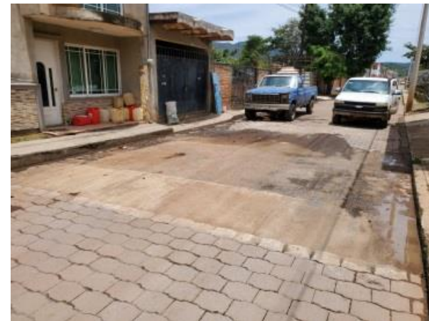
Se realiza marcaje de baches y levantamiento de volúmenes para el proyecto de bacheo de la carpeta asfáltica de la avenida Terebintos
